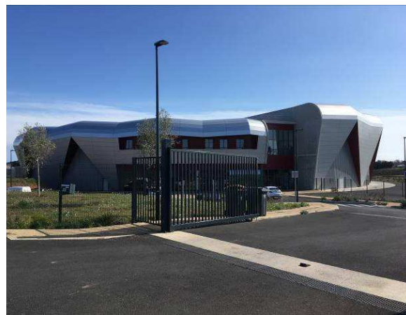
Vue route de Bessan vers la nouvelle cave
